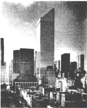
图 3.3-54 纽约花旗公司 278m 高层建筑在其 240m 高度装有自动调节的减振器 资料来源: Planning and Environment Criteria for Tall Buildings (Volume PC) [M], P.852, 1981
